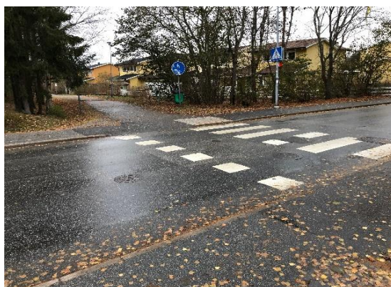
Bild 6. Korsningspunkterna är i behov av hastighetssäkring.
